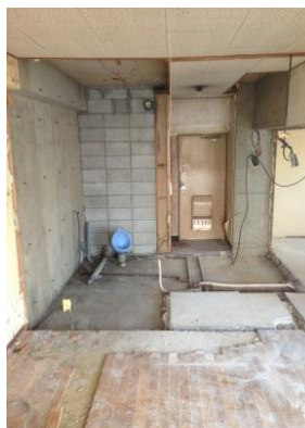
④リビング 工事中
