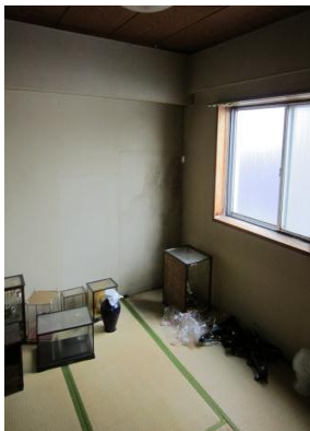
①居室 工事前
